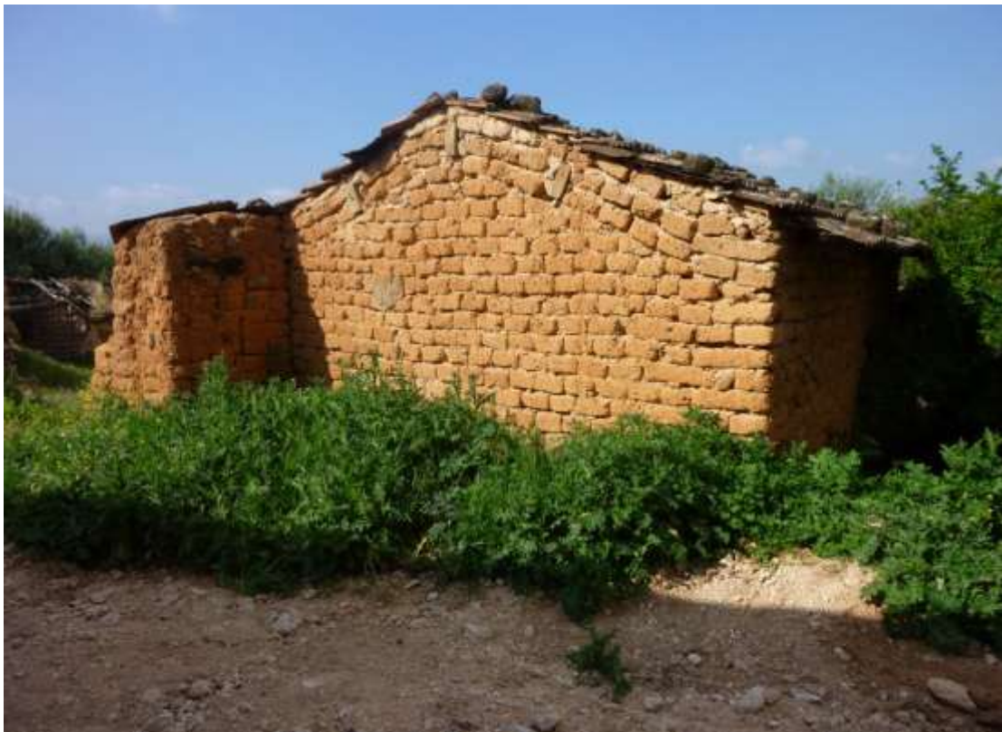
Figure II.3.3(1) : Les murs en pisé d'une maison kabyle traditionnelle.
