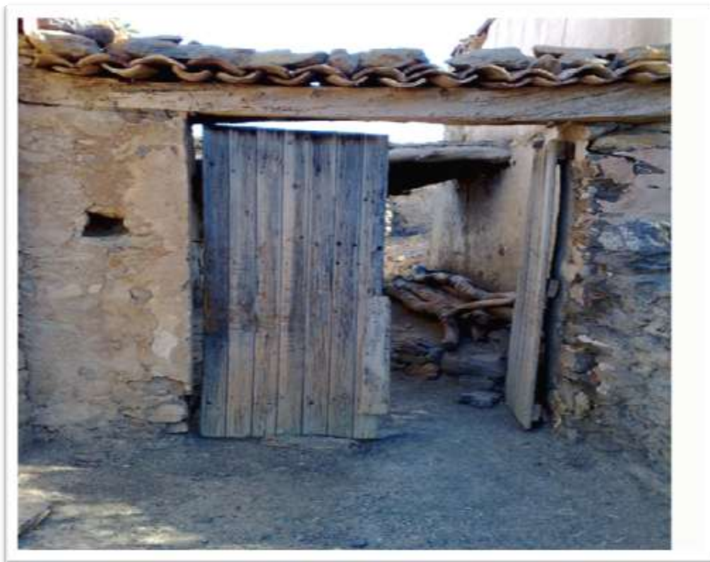
Figure III.1.2. (2) : Asqif d'une maison kabyle traditionnelle source internet : http://www.la.kabyle.com )
