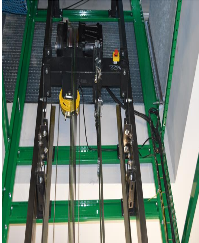
Figure III.29. Mode de fixation de l'ascenseur.
