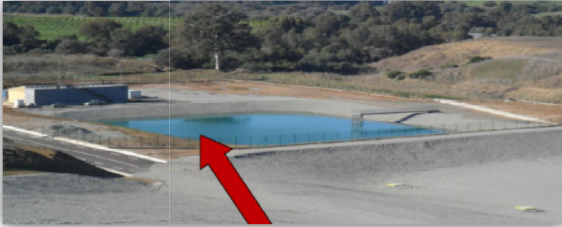
Figure V-14 : Bassin de rétention de lixiviats
