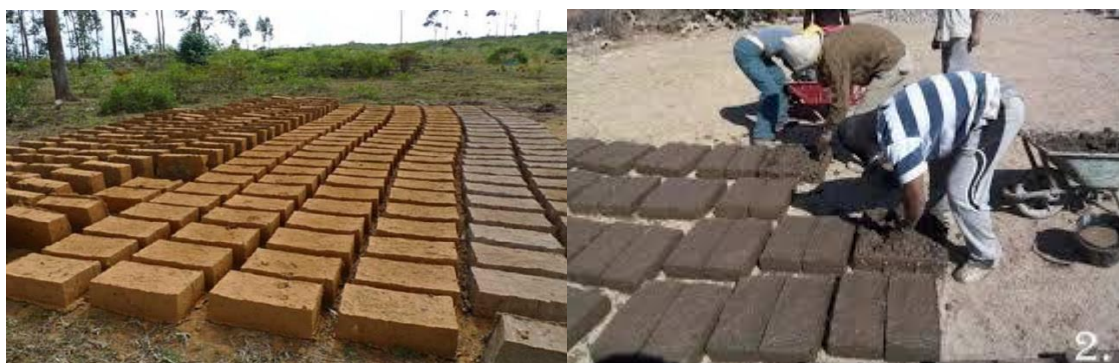
Figure I.8 Moulage et séchage de l'adobe [31.32]
