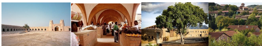
Figure I.3 Exemples récents de constructions en terre. De gauche à droite : le Fort d'Al Jahili; le marché de Koudougou au Burkina-Faso; une école en pisé à Koné en Nouvelle Calédonie; quartier de 65 logements construit à L'Isle-d'Abeau en France [115].
