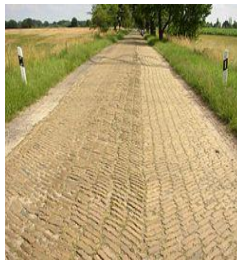
Figure I.29 Route Pāwesin-Riewend pavée de briques, dans le Brandebourg, Allemagne [27]
