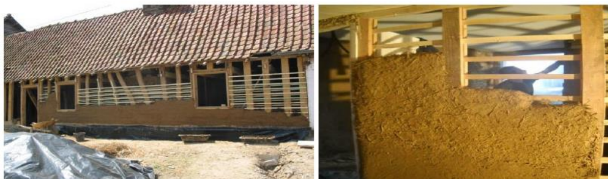
Figure I.17 Technique de construction en Torchis [114].
