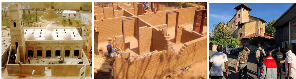
Figure I.15 Quelques réalisations en BTC. De gauche à droite : la Mosquée Al Medy en Arabie Saoudite ; un chantier en BTC en R.D. Congo ; une maison en BTC à L'Isle-d'Abeau en France [11]
