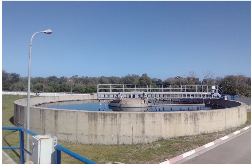
Figure 07 : Décanteur secondaire.
