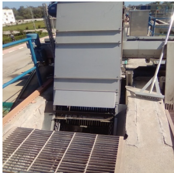
Figure 6: Dégrillage mécanique
