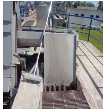
Figure 7: Dégrillage manuelle
