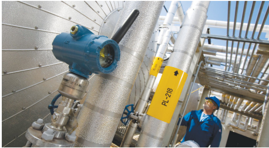
FIGURE 1.9 – Des noeuds capteurs dans une installation industrielle
