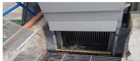
Figure N°4 : Grille mécanique
