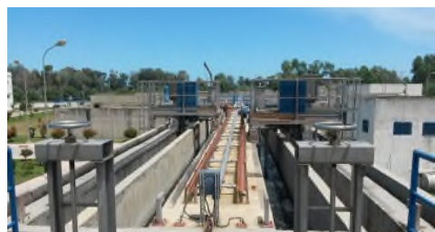
Figure N°5 : pont de déshuilage et dessablage
