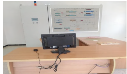
Figure N°12 : salle de contrôle automatique
