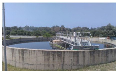
Figure N°7 : Décanteur secondaire
