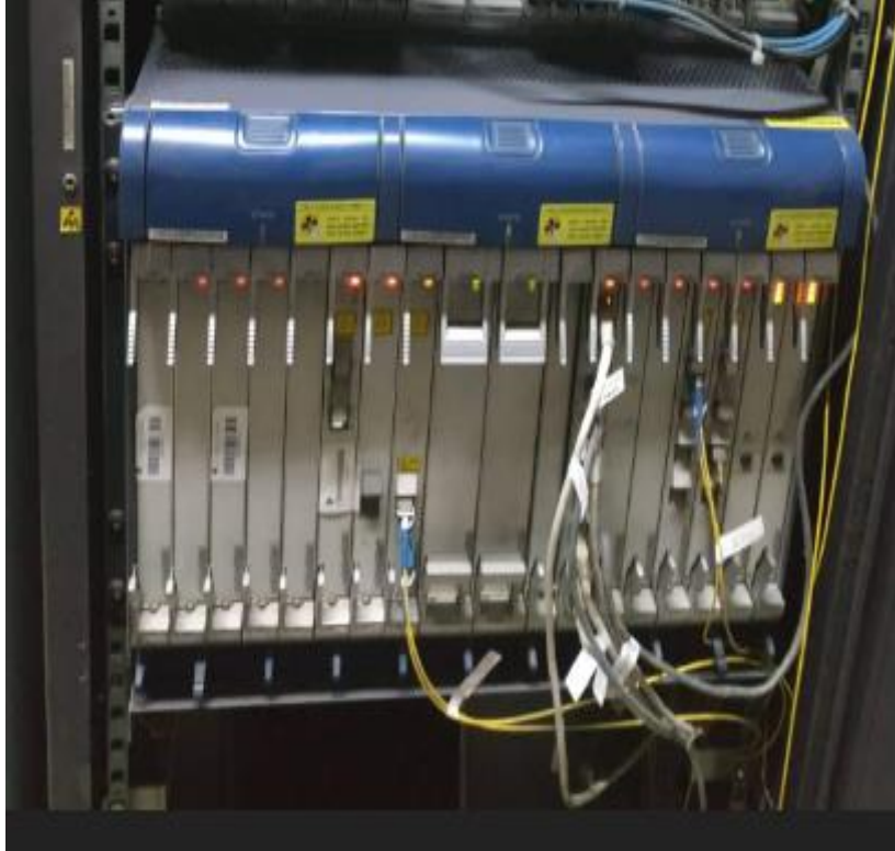
Figure III.4 : Structure de l'équipement HUAWEI OSN 3500.
