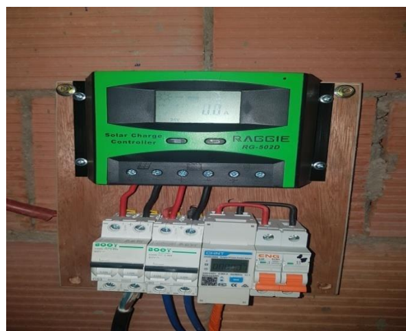
Fig.III.20 : brancher les panneaux et les batteries vers les disjoncteurs puis vers le régulateur
