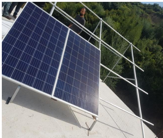
Fig.III.17 : montage des panneaux photovoltaïques sur la structure
