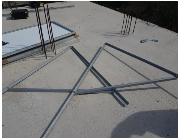
Fig.III.15 : préparation de la structure porteuse des panneaux
