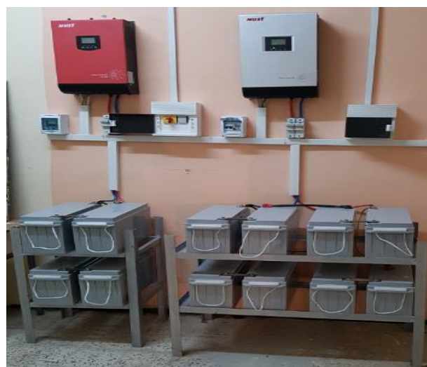
Fig.III.11 : fin d'installation de système photovoltaïque
