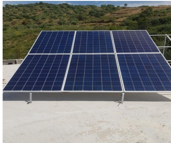
Fig.III.18 : fin de montage des panneaux sur la structure
