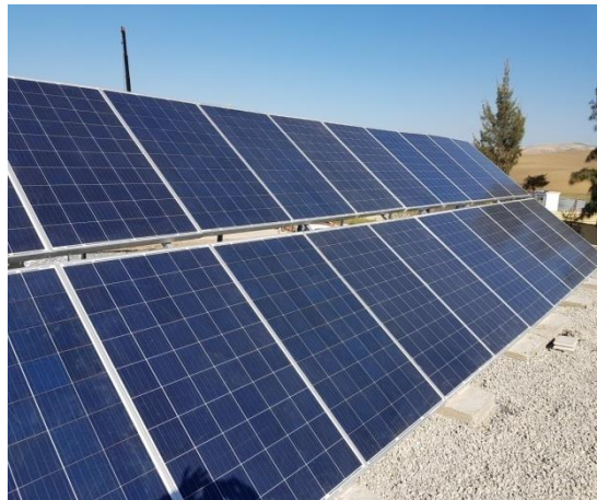
Fig.III.10 : installation des panneaux sur la structure
