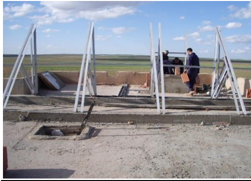
Fig. III.7: Phase de la réalisation du génie civil d'un générateur solaire.
