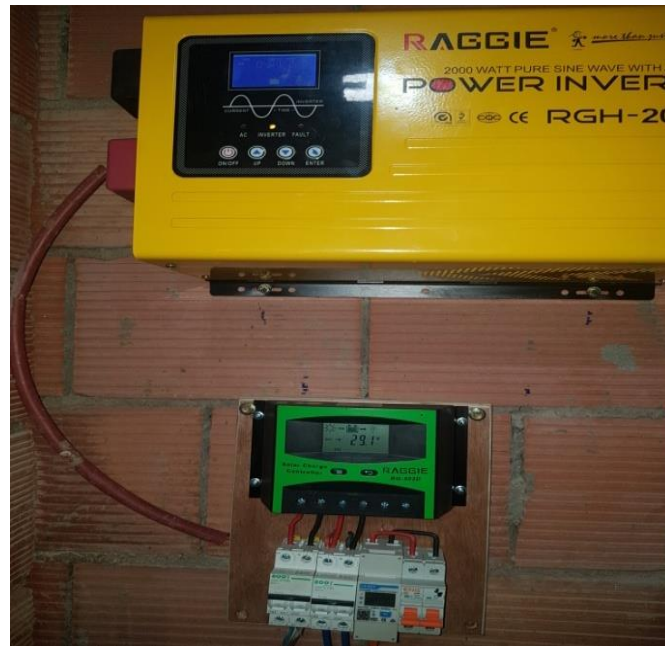
Fig.III.21 : brancher le régulateur vers l'onduleur (2000W/24 V)
