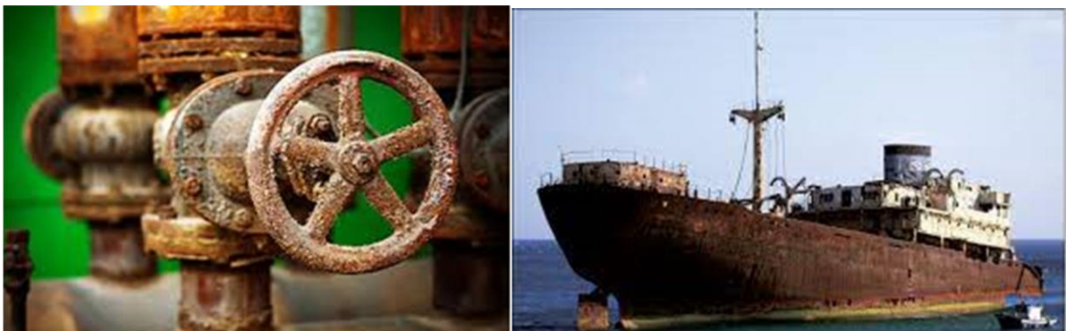
Figure I.1: Photos de matériaux soumis aux phénomènes de corrosion.
