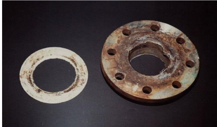
Figure I.6: Corrosion caverneuse d'un acier allié sous un joint [15].
