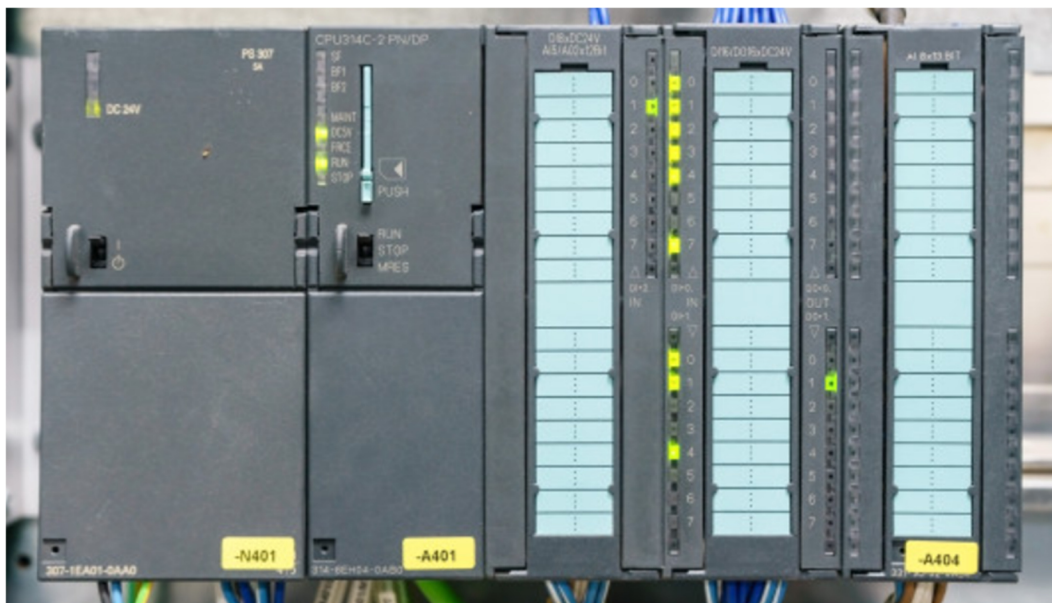
Figure III.1 Exemple d'un API modulaire
