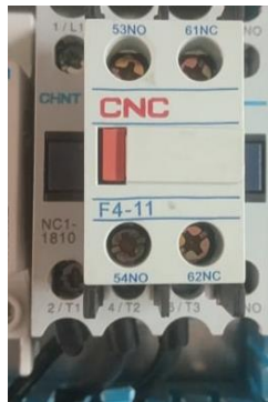
Figure III.24 : Contacteur de commande
