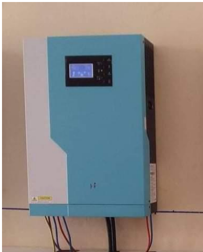
Figure III.8 : Onduleur de 5kVA
