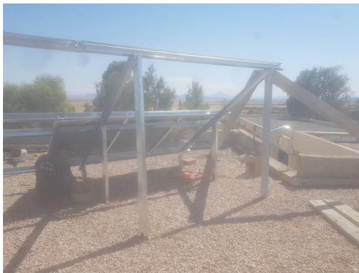
Figure III.4 : La structure porteuse des panneaux
