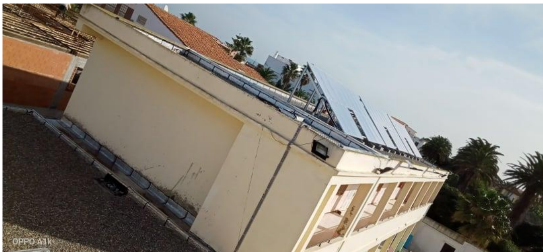
Figure III.6 : L'installation des panneaux
