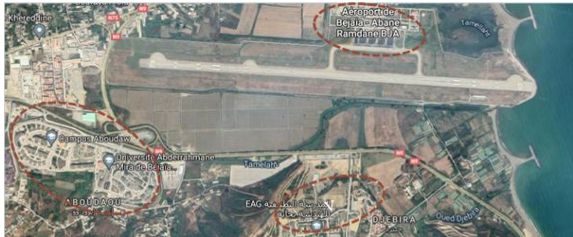
Figure A. 2: Les équipements présents dans le site.
