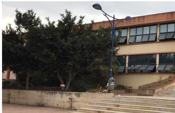
Figure 3. 3: Ecran végétal arborant la façade Sud-ouest du bloc architecture.
