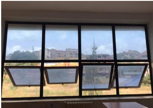
Figure 3. 7: La baie vitrée des salles n°05 et n°09.
