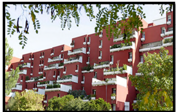
Figure 26: Image illustrant la résidence des terrasses à Talence, Bordeaux, qui est lisible formellement Source : www.talence.fr
