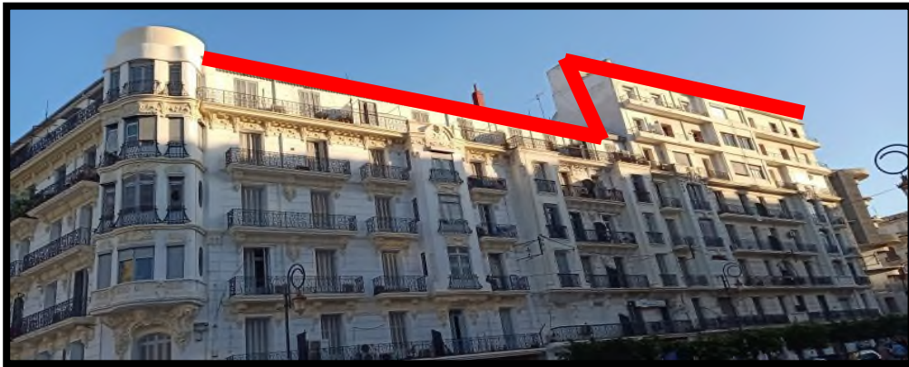
Figure 46: Image illustrant le sky-line, immeuble Haussmannien à Alger centre
