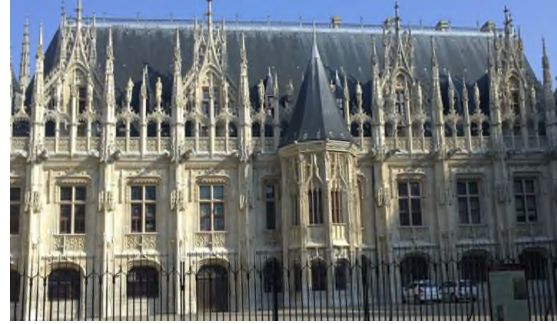
Figure 102: Palais de justice de Rouen après restauration
