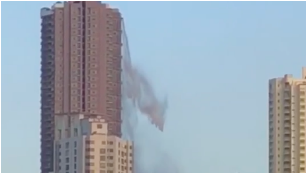
Figure 1.3: Ballotement dans la piscine du toit d'un gratte-ciel lors d'un séisme [1]
