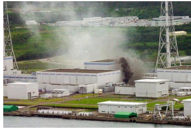
Figure 1.8: Séisme endommageant une centrale nucléaire. 16 juillet 2007, Japon
