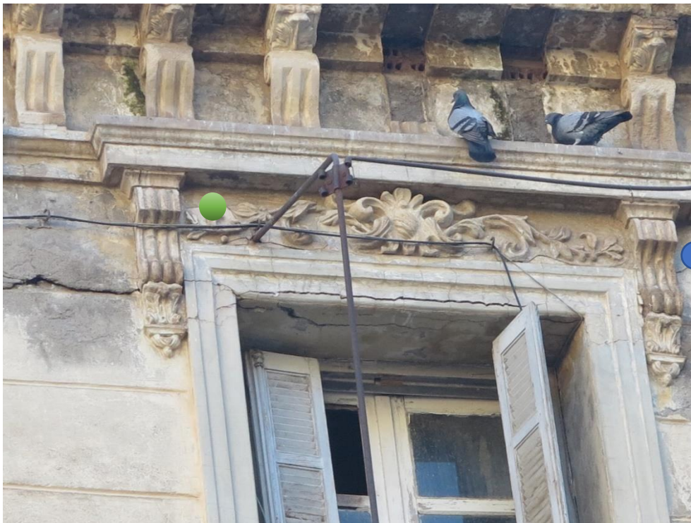
Figure 65 :CARTOUCHE SUR FENETRE ET CORBEAU SOUS SAILLIE
