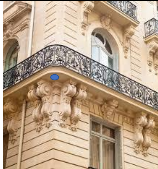
Figure 18 immeuble haussmannien – 7 ème arr- Paris (site consulté le 05-02-2022)
