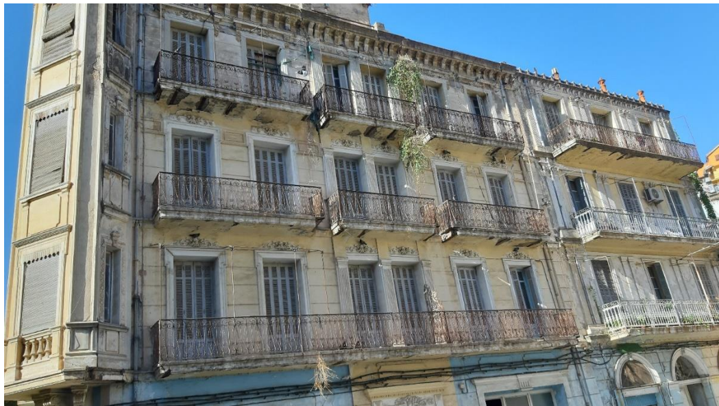
Figure 53 : photo de l'immeuble BOULIMAT – photo prise par l'auteur (2020)
