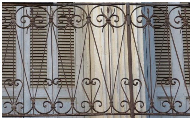
Figure 62 :BARREAUDAGE SUR CORRIDOR
