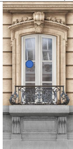
Figure 07 : décor façade haussmannienne – koziel.fr (site consulté le 05-02-2022)
