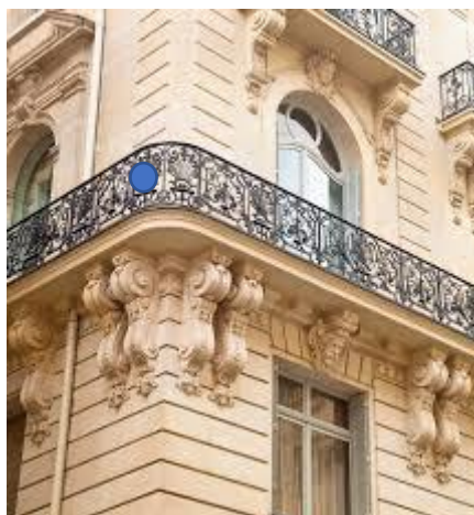
Figure 06 : immeuble haussmannien – 7 ème arr- Paris (site consulté le 05-02-2022)
