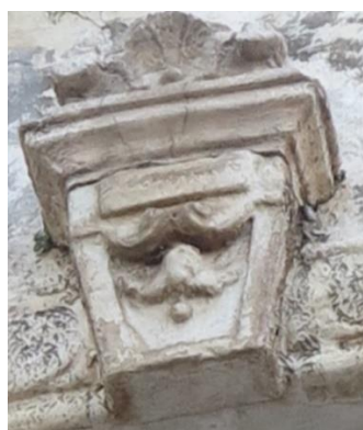
Figure 58 :ORNEMENT SUR LES FENETRES DU BOW-WINDOW – MMEUBLE BOULIMAT
