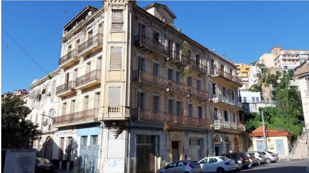
Figure 50: photo de l'immeuble BOULIMAT – photo prise par l'auteur (2020)
