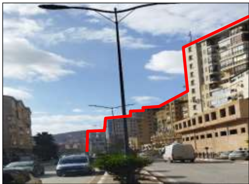
Figure 84 : vue sur les parois de la voie
