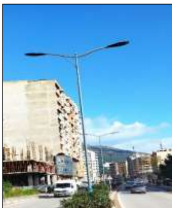
Figure 86 : éclairage urbain. Source : auteur
