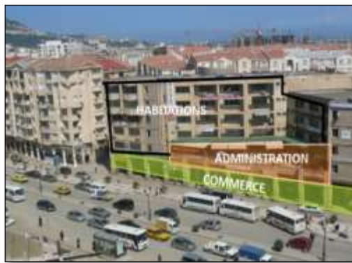
Figure 85 : les activités déroulées sur les parois de la voie
