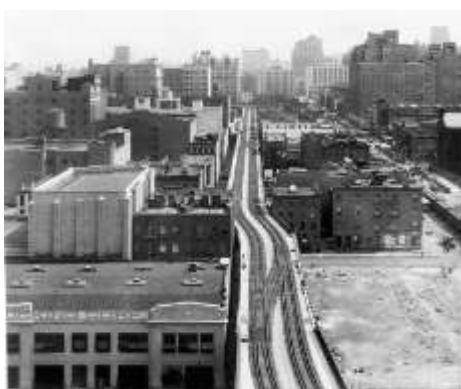
Figure 16: a voie ferrée surélevée
