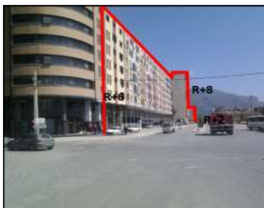
Figure 95 : vue sur les gabarits de boulevard
