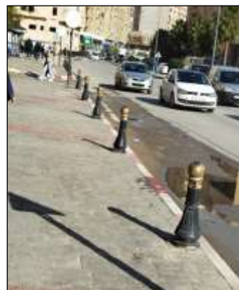
Figure 408 : les bornes Source : auteur
