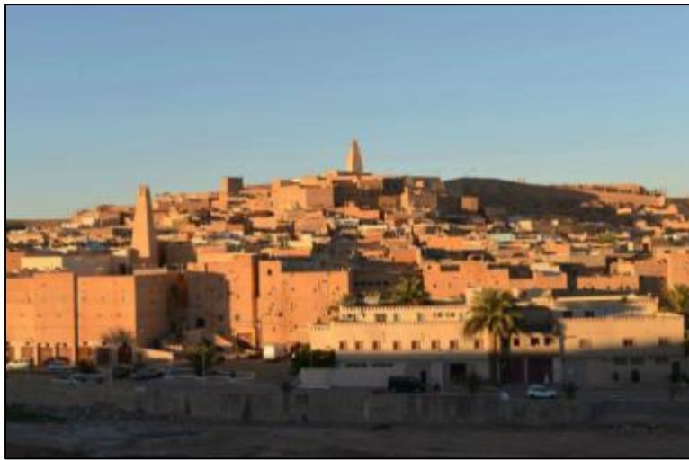
Figure 17 : Vue panoramique sur le Ksar de Béni-Isugen
