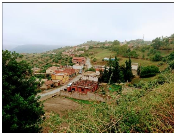
Figure 57 : Vue globale sur le terrain d'intervention
