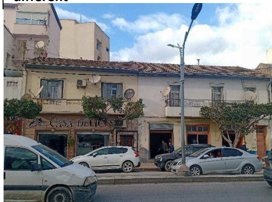
Figure 73 : Traitement de façade différent
