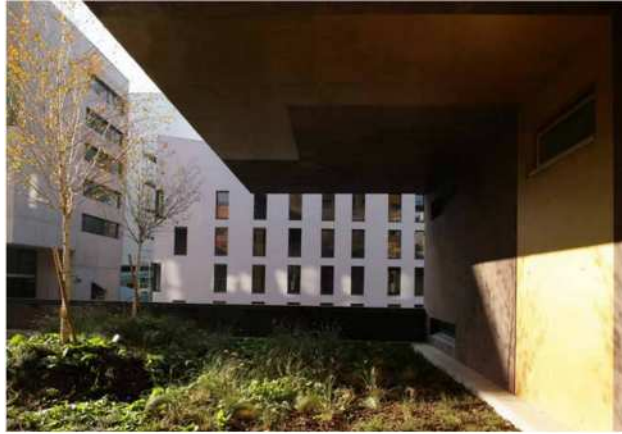
Figure 42 terrasse verte accessible
