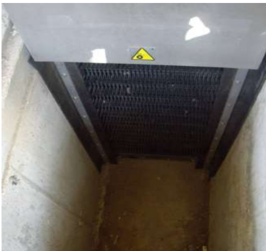
Figure 1.4 :Dégrilleurs fins.
