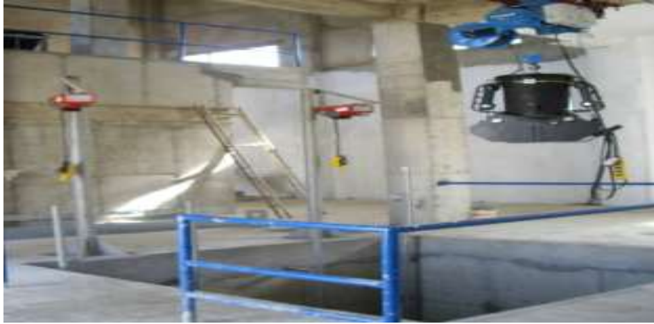
Figure 1.3 :Dégrilleur grossier.
