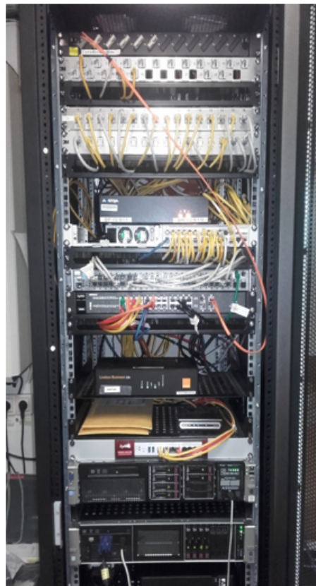
FIGURE 2.5 – L'armoire de brassage [2]
