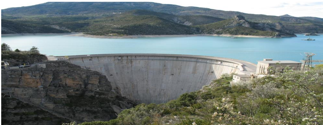
Figure II-5 barrage voûte de Castillon, France [12]
