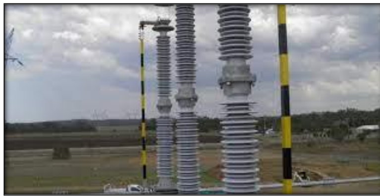
FigII.2 : sectionneur mise à la terre.
