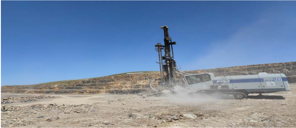
Figure I.1 : Sondeuse en train de foration des trous.
