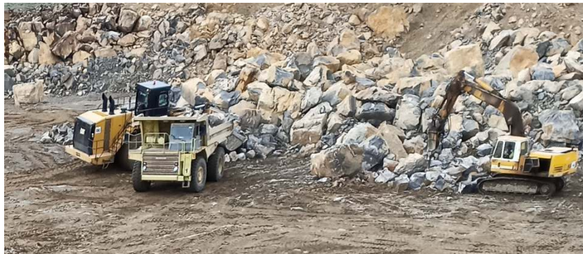
Figure II.8 : les blocs hors-gabarits
