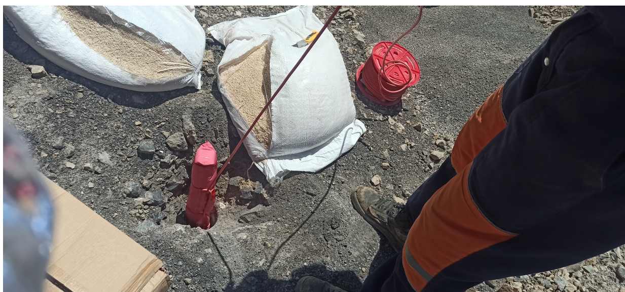
FIGURE III.4 – Amorçage de l'explosif.
