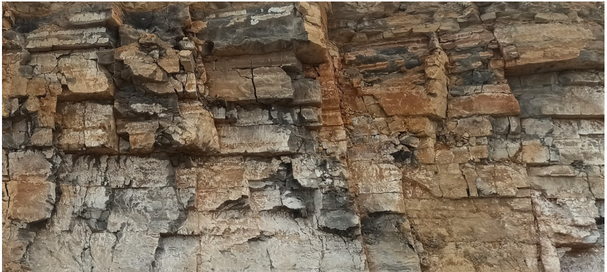
FIGURE I.5 – Les joints d’un bloc fracturé sur le deuxième gradin de Medjounes 2 carrière de Ain-El-Kebira
