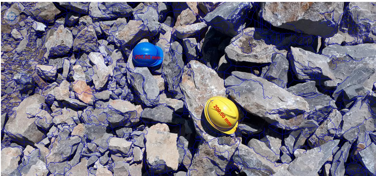
Figure III-14 : prise de photo avec deux casques comme échelle de mesure
