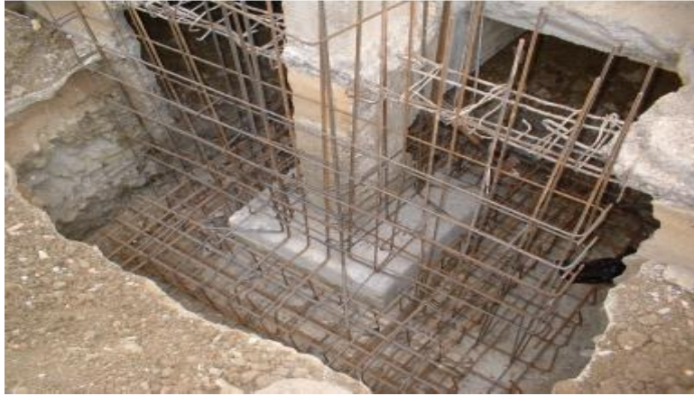
Figure 84. Mise en œuvre des semelles de renforcement
