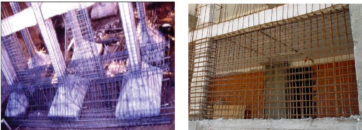
Figure 77. Injections des voiles en béton armée.
