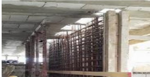
Figure 82. Disposition des étaitements
