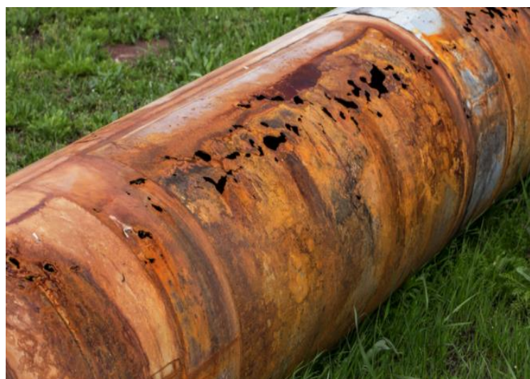
Figure I.4- Corrosion par piqûres d'un pipeline[2].
