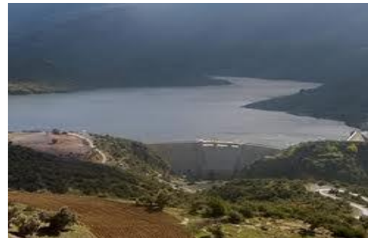
Photo n°22 : Barrage Tichy Haf.
