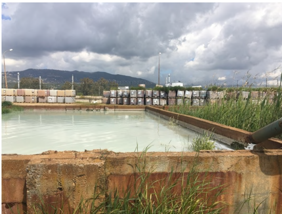
Figure I.4 : Image prise à l'ENIEM pour les lits de séchage.
