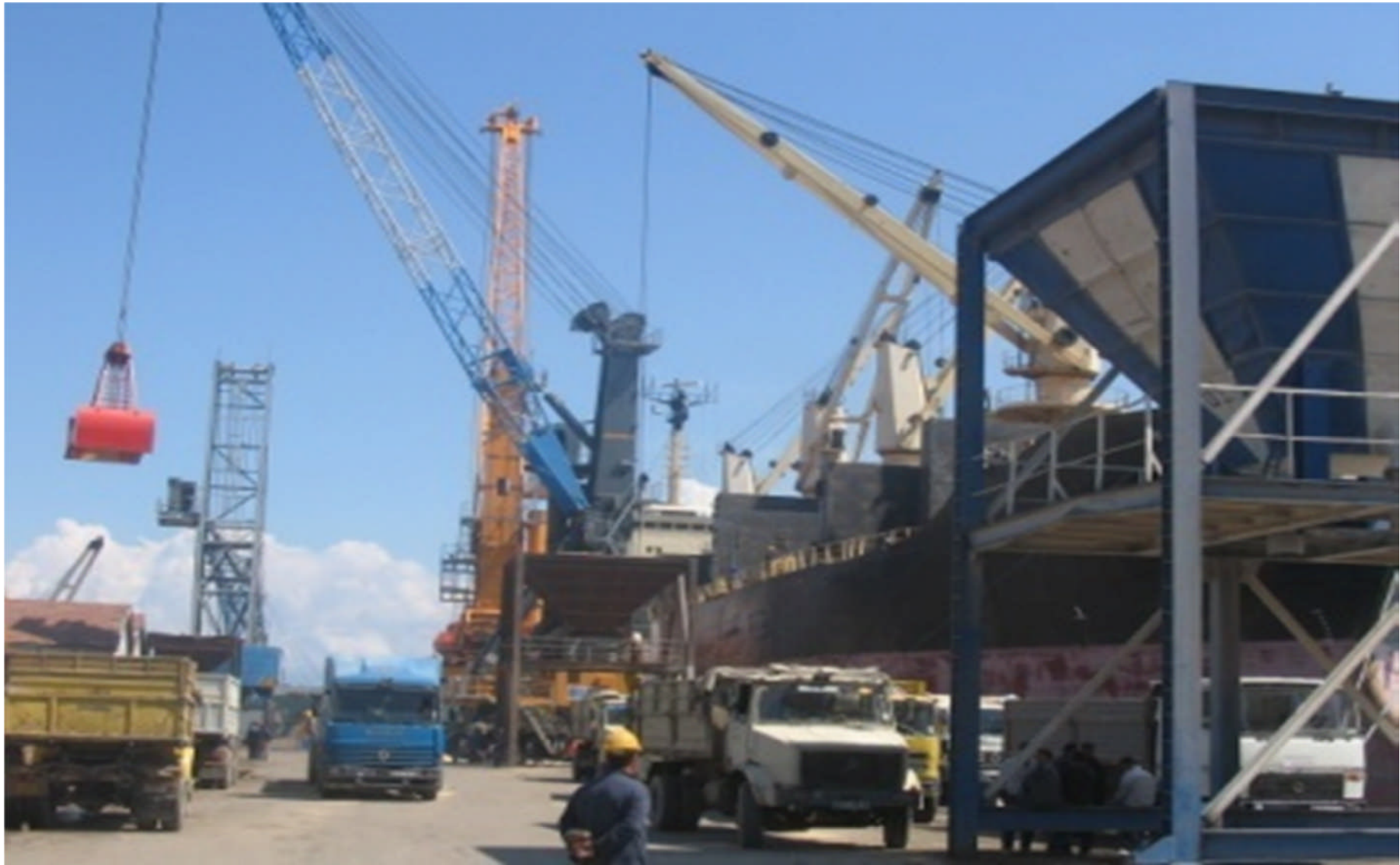
Photo N°01 : Cette photo nous montre les travailleurs qui sont exposés au danger surtout lors du chargement et du déchargement de la marchandise (Dockers).
