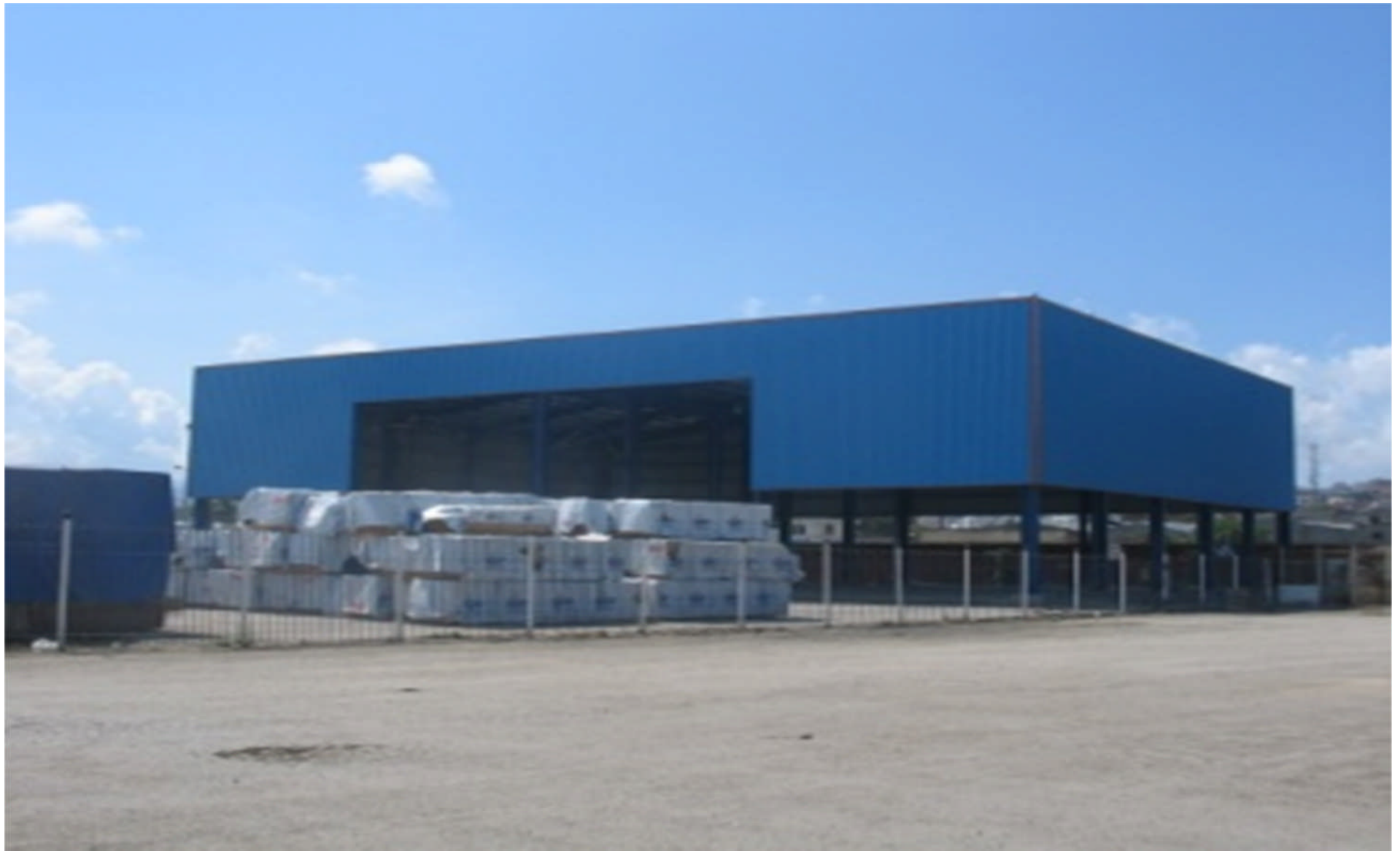
Photo N°08 : Cette photo représente le Centre de Transit de Marchandises Dangereuses (CTMD), il faut mettre en disposition un dispositif de sécurité important.
