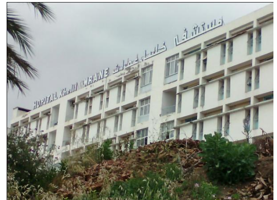
Figure 10 : Hopital Khelil Amrane. Photo prise le 02 Mai 2016
