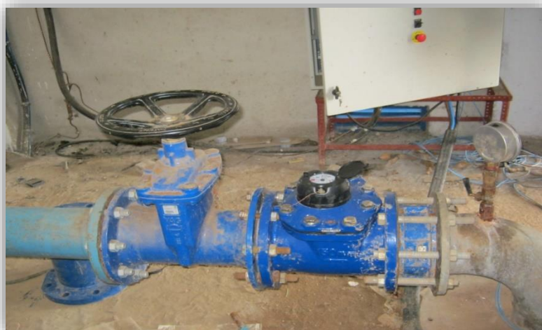
Figure III.11 : Vue intérieure du forage 10
