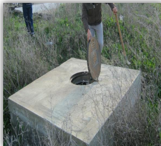
Figure III.14 : Vue à l'extérieur de la chambre de vannes
