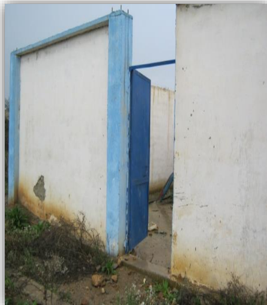
Figure III.5 : Vue extérieure d'entrée du forage 4
