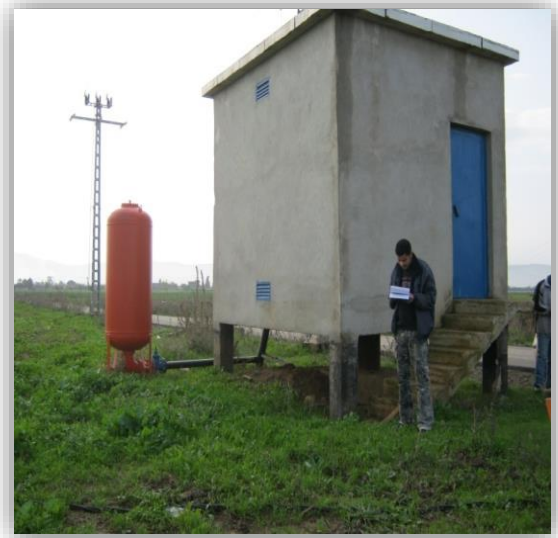
Figure III.10 : Vue extérieure d'entrée du forage 10
