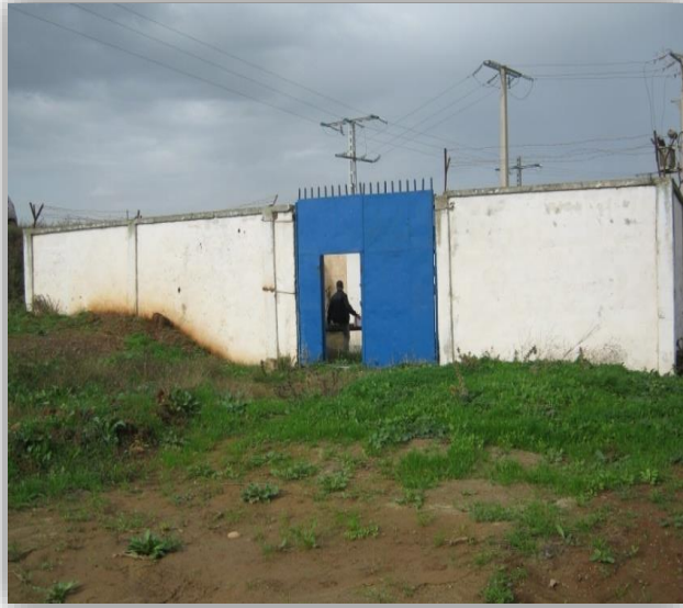
Figure III.3 : Vue extérieure d'entrée du forage 3
