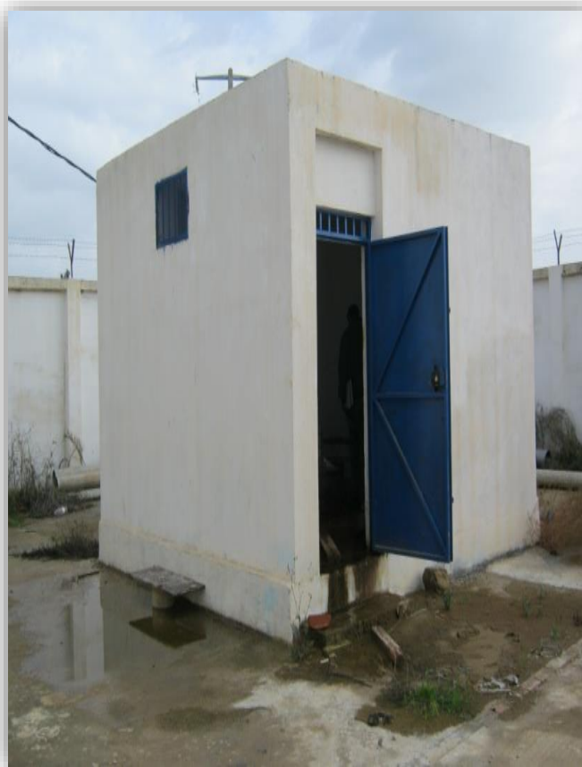
Figure III.1 : Vue extérieure du forage 2
