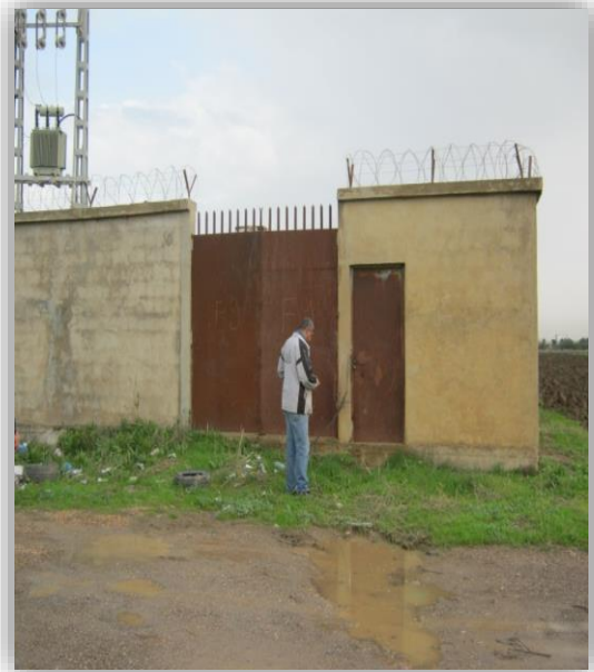
Figure III.8 : Vue extérieure d'entrée du forage 9
