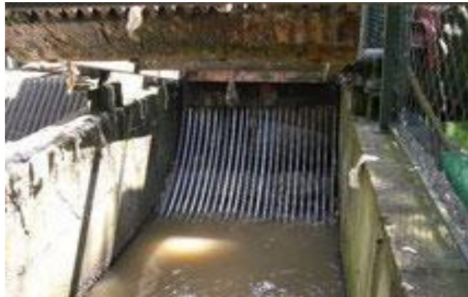
Figure (III,3) : grille automatique.
