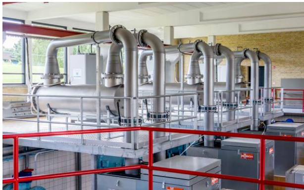
Centrale à Ultraviolets
