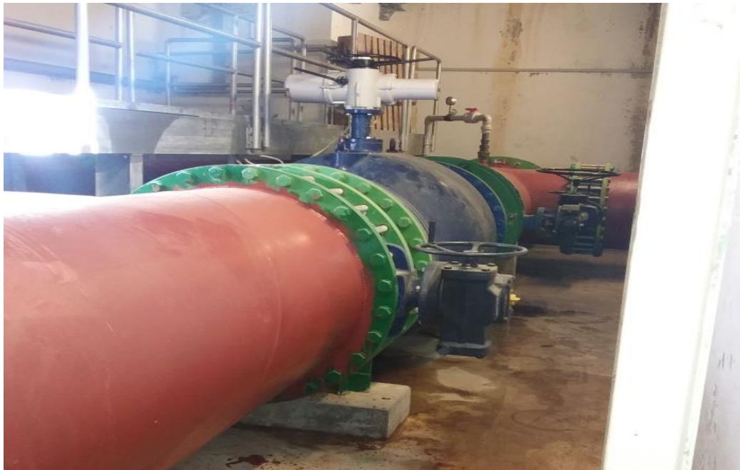
Figure II.2 : Photographie de l'ouvrage d'entrée.
