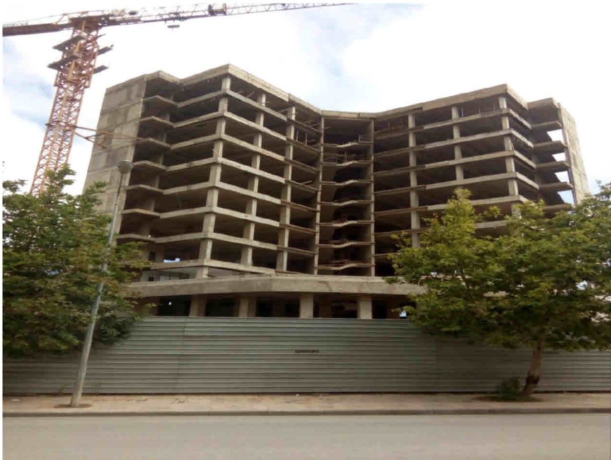
Fig.I.1 Projet en cours de réalisation
