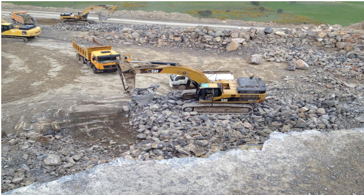
Figure II.9 : Opération de chargement des matériaux (photo prise durant notre période de stage au sein de l'unité UMABT)
