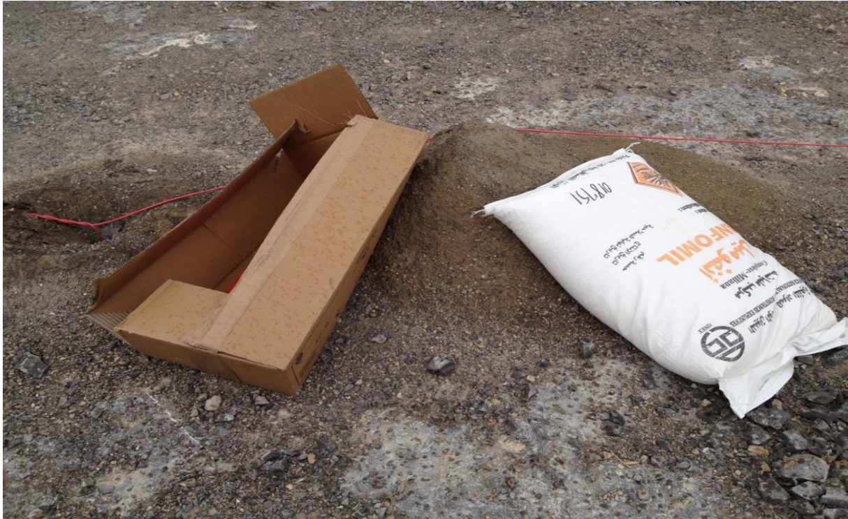
Figure II.6 : Les trous de mines lors du chargement en explosifs (ANFOMIL) (photo prise durant la période de notre stage).
