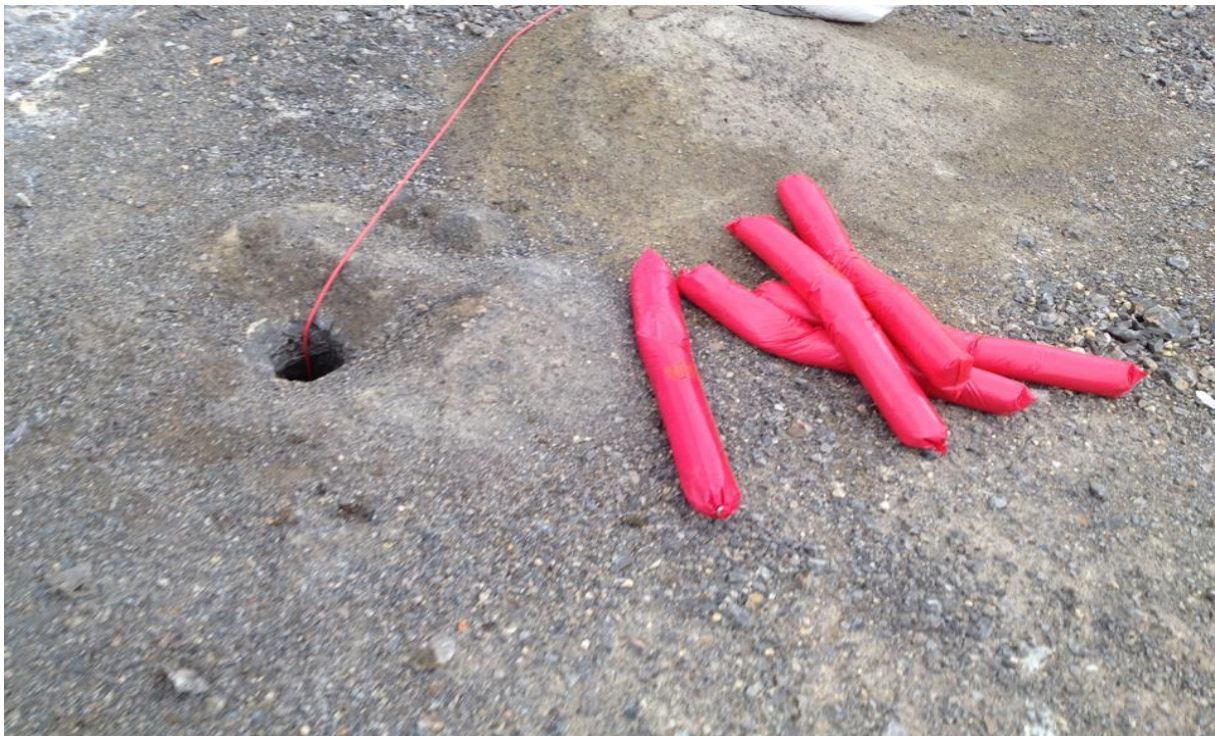
Figure II.5 : Les trous de mines lors du chargement en explosifs (MARMANIT) (photo prise durant la période de notre stage).
