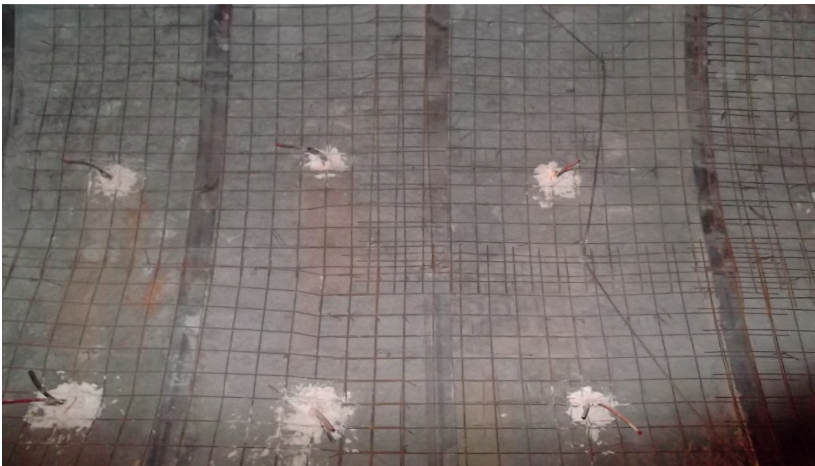
Figure IV.5 : des cintres écartés entre eux de 1.5 m
