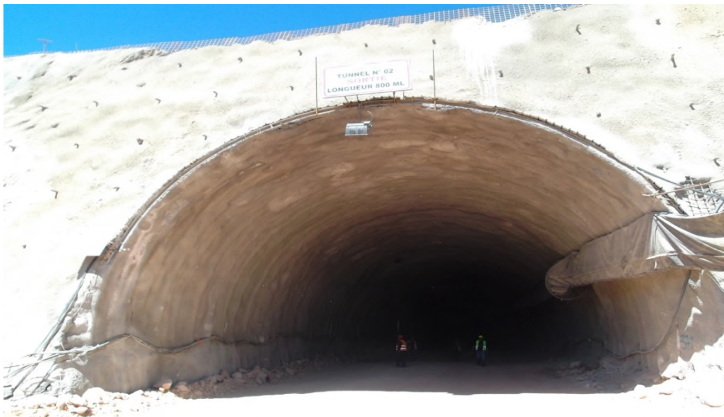
Figure IV.1 : la vue d'entrée du tunnel T2
