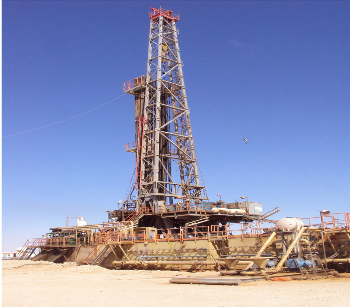
Figure II 8 : Appareil de forage TP 201 ENTP. (12/03/2015)
