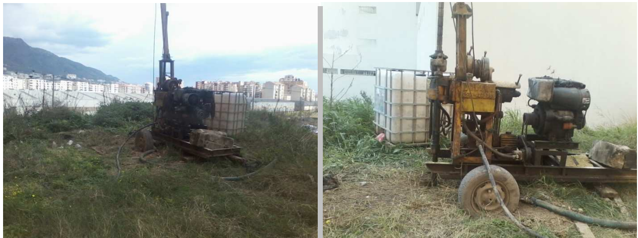
Photo N°01 & 0 2 : Sondages Carottés (Sondeuse géotechnique).
