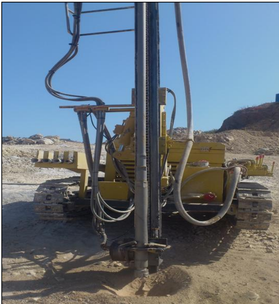
Figure IV.4 : Chiot de forage (foreuse), (Photo carrière de SARL NOSTRAP, 04/2016).
