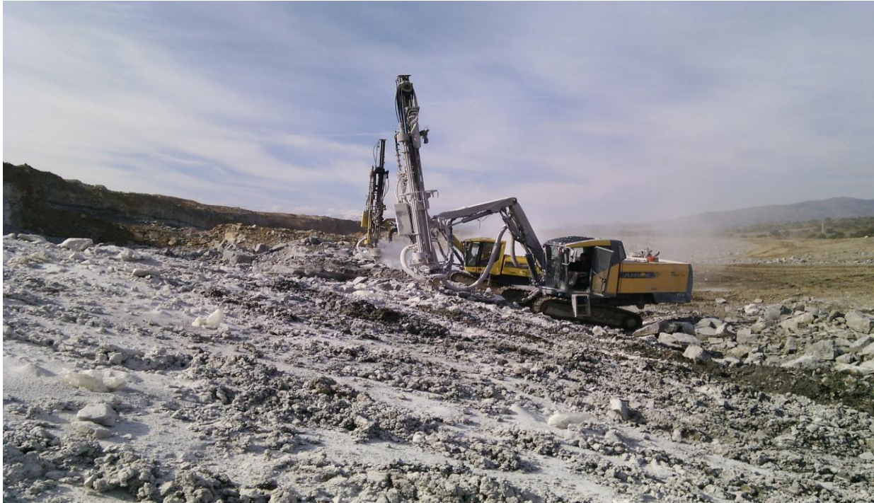
Figure IV.5 : Opération de Foration à l'aide d'une sondeuse (photo ; 2016).
