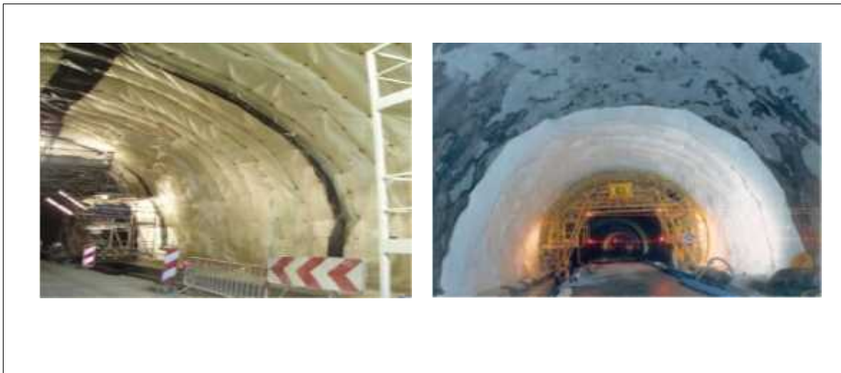
Figure I.13. Etanchéité d'un tunnel.
