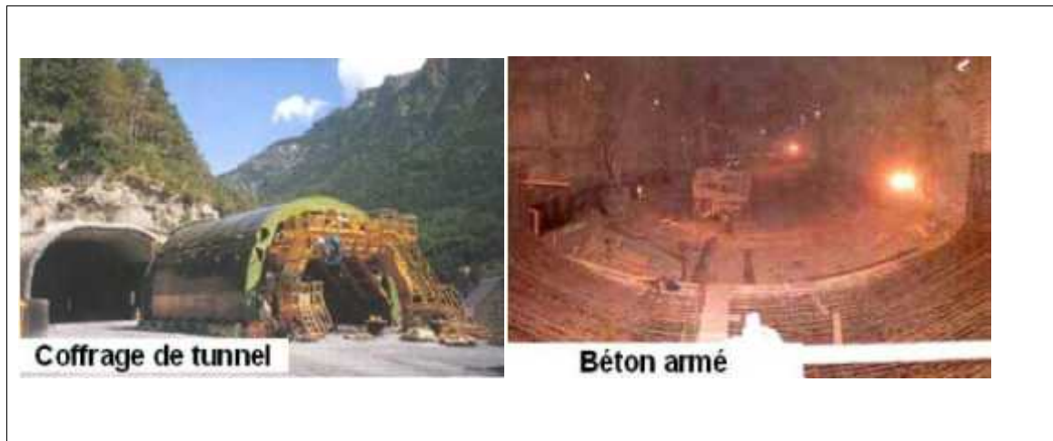
Figure I.14. Types de revêtement des tunnels.
