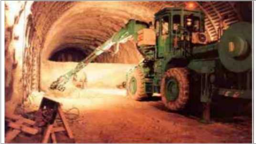
Figure I.7. Creusement en demi-section. [9]
