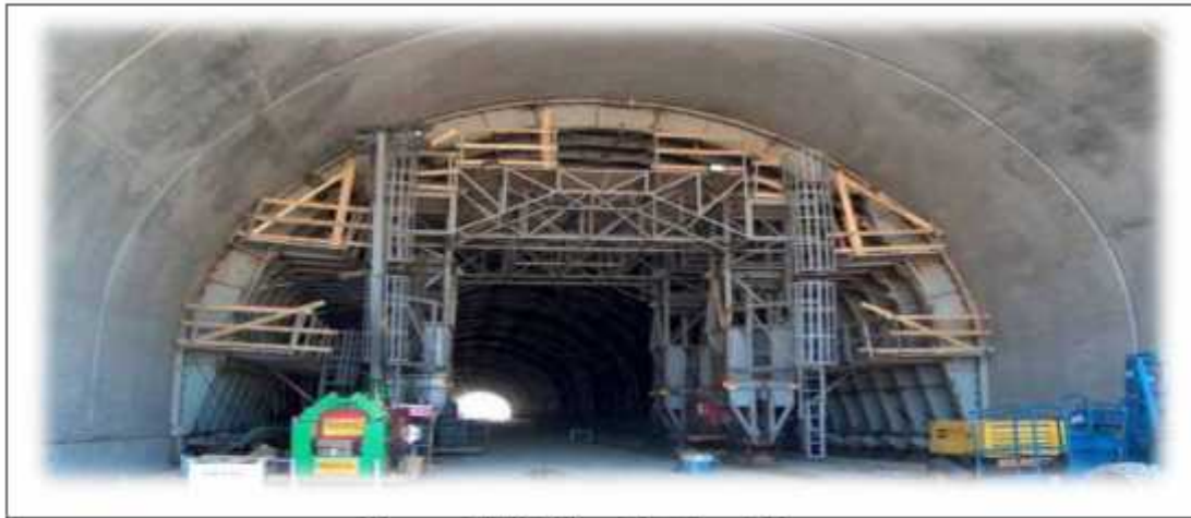
Figure IV.8. Charriot de coffrage.
