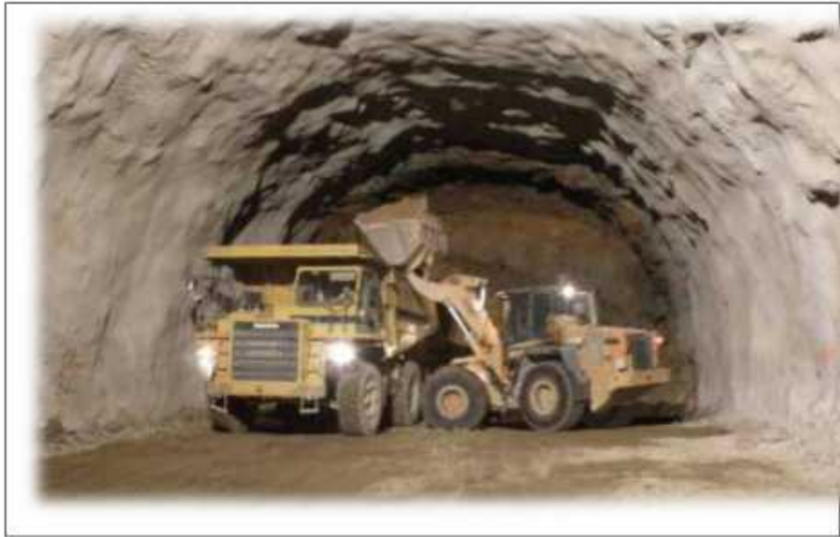
Figure IV.1. Travaux de déblai dans l'intérieur de tunnel.
