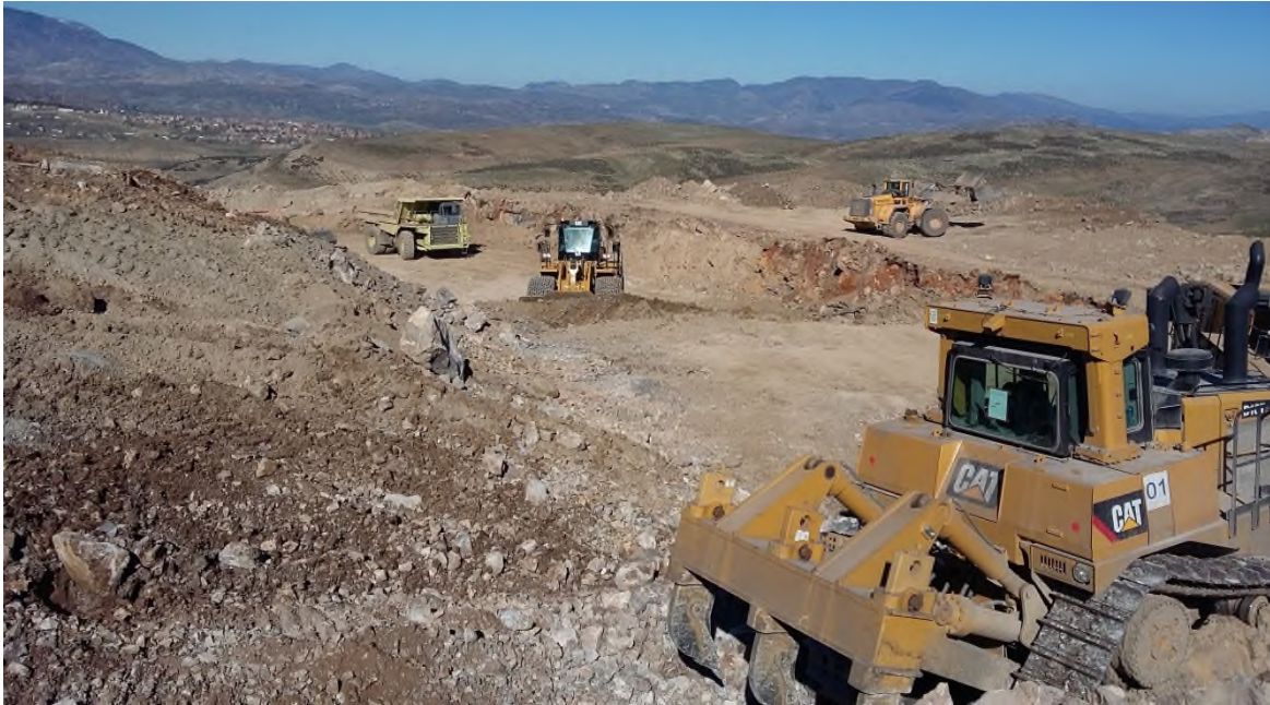
Figure I.02 : Traçage d'une piste d'accès au niveau supérieure de la carrière Ain Kebira.
