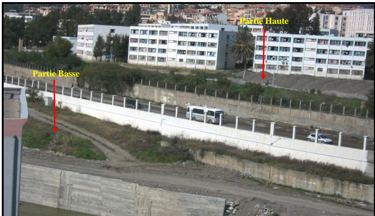
Figure I.5 : Vue d'ensemble du site du glissement.
