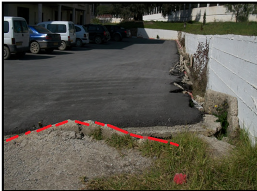
Figure I.9 : Des bombements enregistrés sur l terrasse rectorale.
