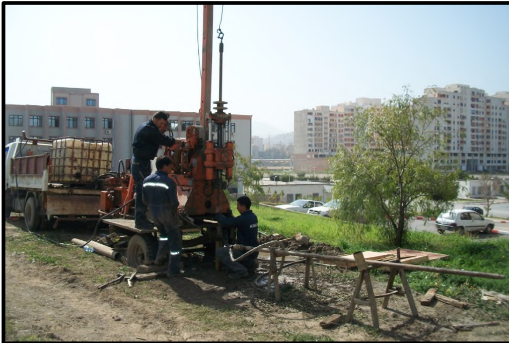
Figure II.1 : Implantation d'un point de sondage carotté.
