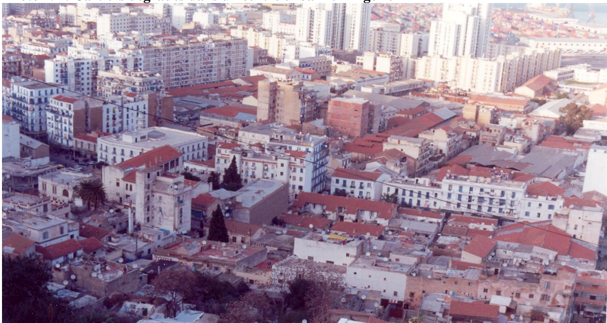
Photo 4.1 : Cartiers dégradés dans un centre urbain en Algérie
