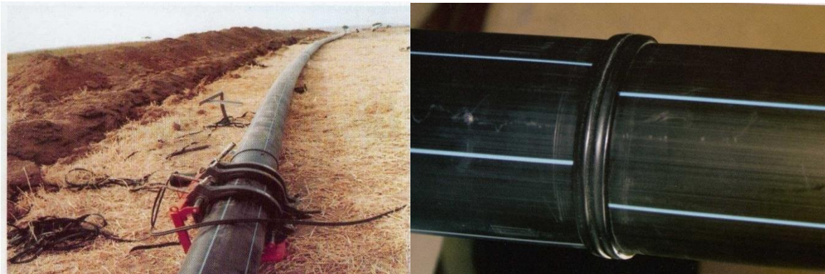
Figure (III.4) : les étapes du soudage bout à bout
