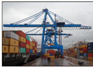
Grue de quai (QC)
