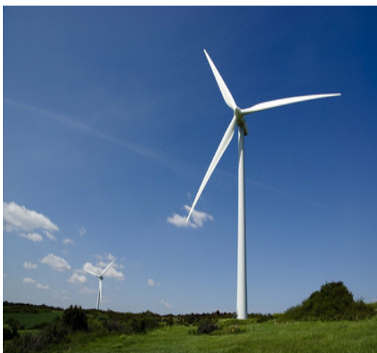
Eolienne à axe horizontal
