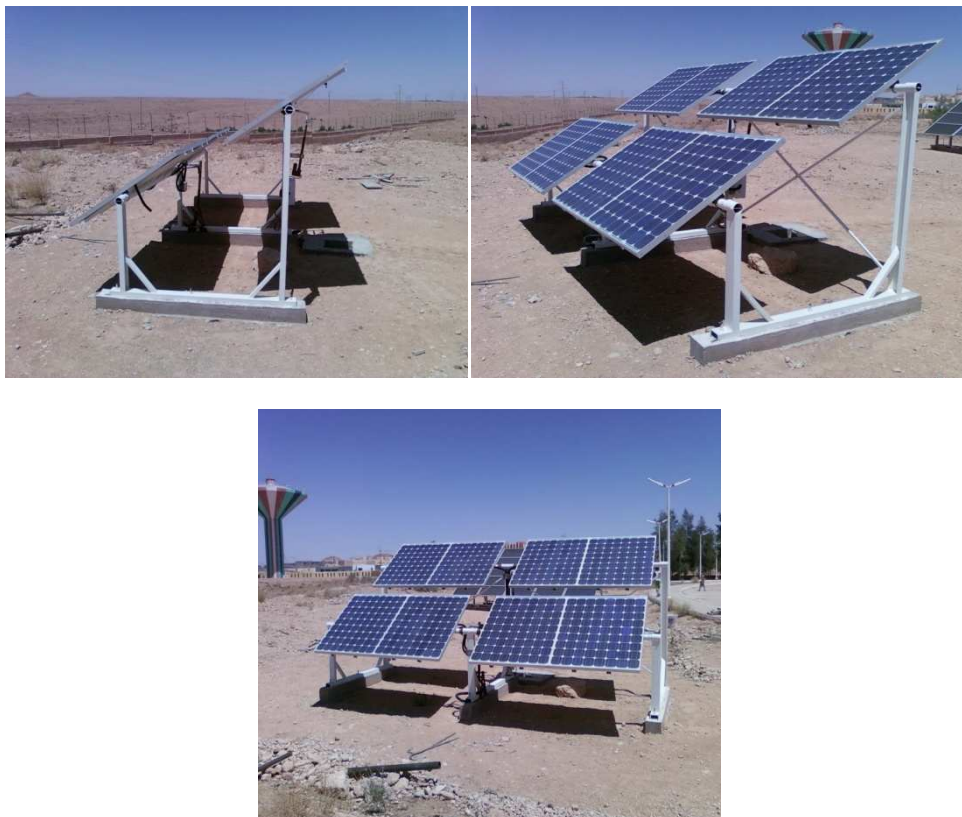
FigIV-15 : Les panneaux(panneau 130Wc et un voltage de 24V).
